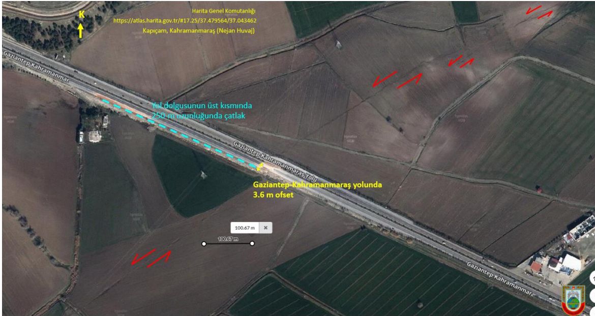
Şekil 8.6. Fay yüzey kırığı ve Gaziantep-Kahramanmaraş yolunda 3.6 m ofset, asfalt yolda birkaç noktada çatlaklar, yol dolgusunda şev duraysızlığı, yol dolgusunun üst kısmında ve asfaltta 250-m'den daha uzun çatlak. Kıpıçam yakını, Kahramanmaraş (Uydu görüntüleri Harita Genel Komutanlığı tarafından atlas.harita.gov.tr websitesi üzerinden sağlanmıştır)
