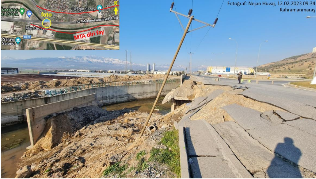
Şekil 8.5. Bir su kanalı kenarındaki yolda heyelan, çatlaklar ve hasar, betonarme istinat duvarında kanala doğru yanal ötelenme, eğilmiş bir elektrik direği. Kahramanmaraş'ın güney kesimi. (fay verisi Emre vd. (2013)'den alınmıştır).
