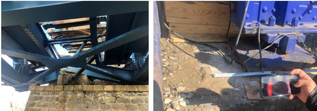
Şekil 6.4. Mesnet kayması ve hareketliliği
