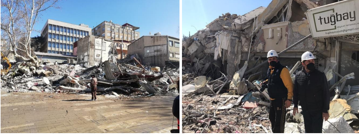
Şekil 5.1. Antakya ve Kahramanmaraş'ta göçen binalar
