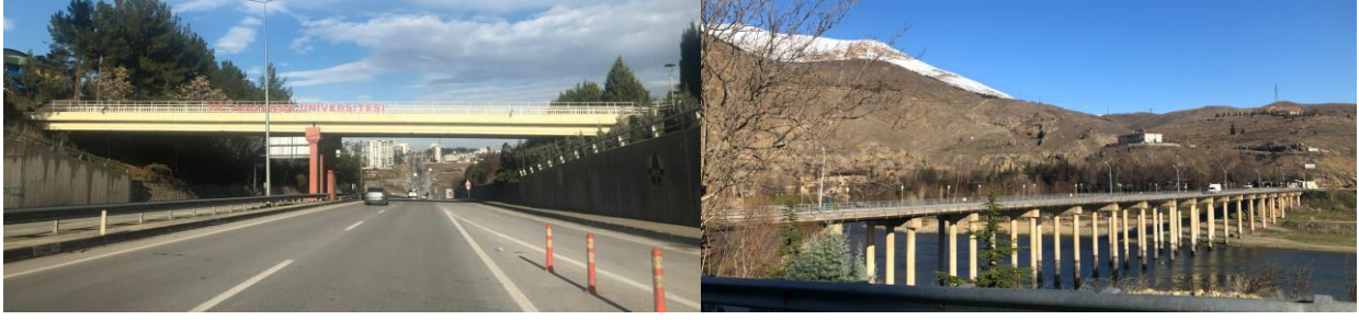
Şekil 6.8. Hasarsız köprülerden örnekler
