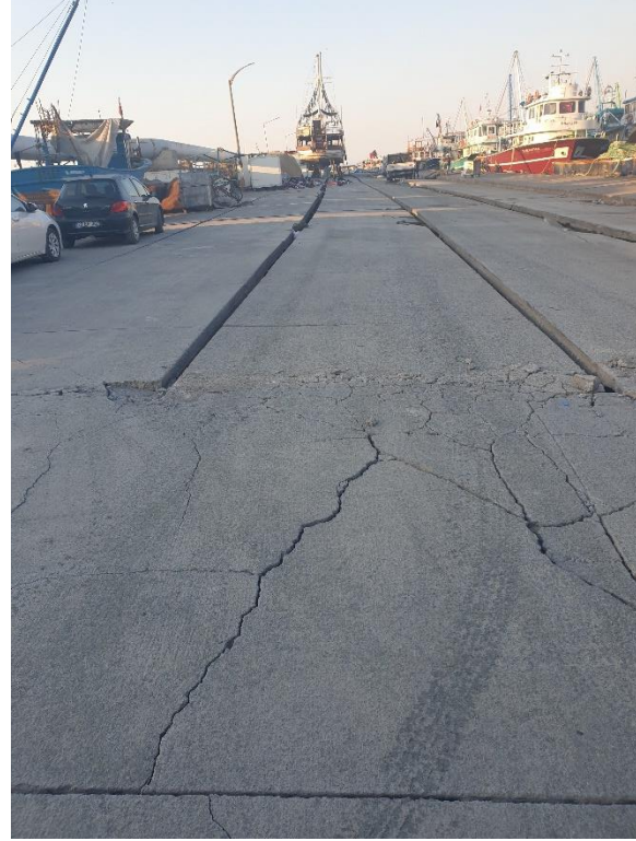
Şekil 7.4. İskenderun Balıkçı Barınağındaki yapısal hasarlar, sıvılaşma sebepli yanal yayılma izleri
