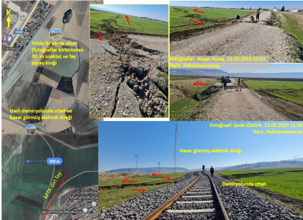
Şekil 8.4. Demiryolu raylarında ve yollarda fay yüzey kırığı ve yanal atım kaynaklı ofset, çatlak ve yarılmalar, hasar görmüş bir elektrik direği (Narlı, Kahramanmaraş yakını). (fay verisi Maden Tetkik ve Arama Genel Müdürlüğü yayını olan Emre vd. (2013)'den alınmıştır)
