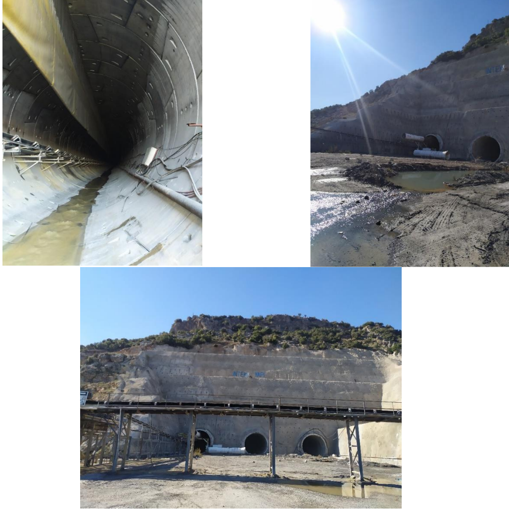
Şekil 4.8. Yapımı devam eden Bahçe-Nurdağ demiryolu tüneli Nurdağı/ Gaziantep (37.16989°N, 36.70806°E)
