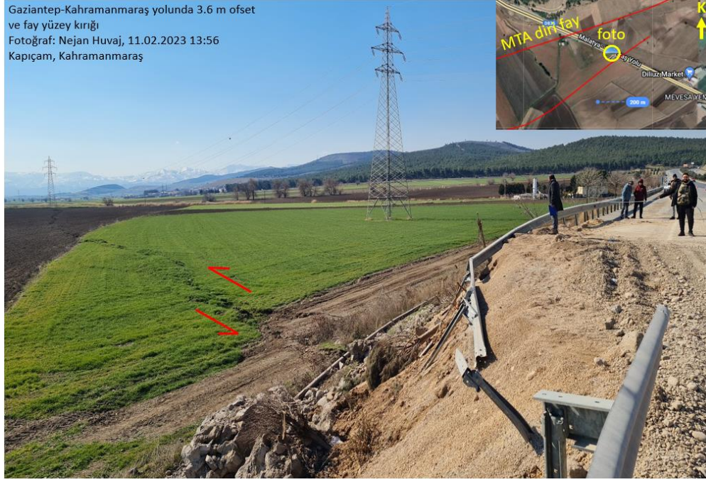
Şekil 8.7. Fotoğrafların yerleri Şekil 8.6’da görülebilir: yüzey fay kırığı ve Gaziantep-Kahramanmaraş yolunda 3.6 m ölçülen ofset (fay verisi Emre vd. (2013)’den alınmıştır).
