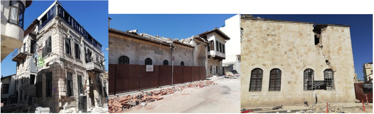
Şekil 5.9. Yığma yapılarıdaki hasarlar
