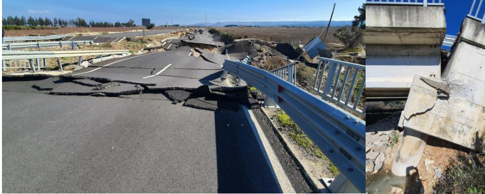
Şekil 6.1. Sıvılaşma ve kenar ayak dönmesi
