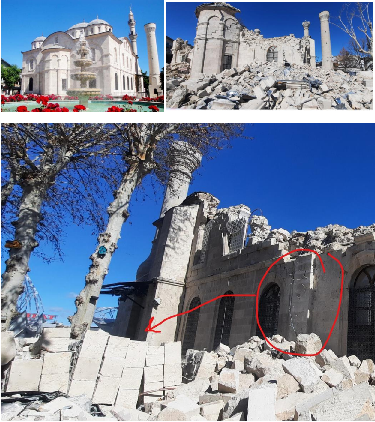
Şekil 9.4. Yeni Cami, öncesi ve sonrası fotoğrafları ve yıkılan bir payandanın görüntüsü.
